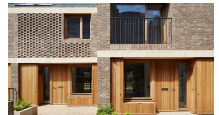
HOUTEN ACCENTEN IN DE PLINT GEVEN DE WONINGEN EEN VRIENDELIJK EN DUURZAAM KARAKTER.
