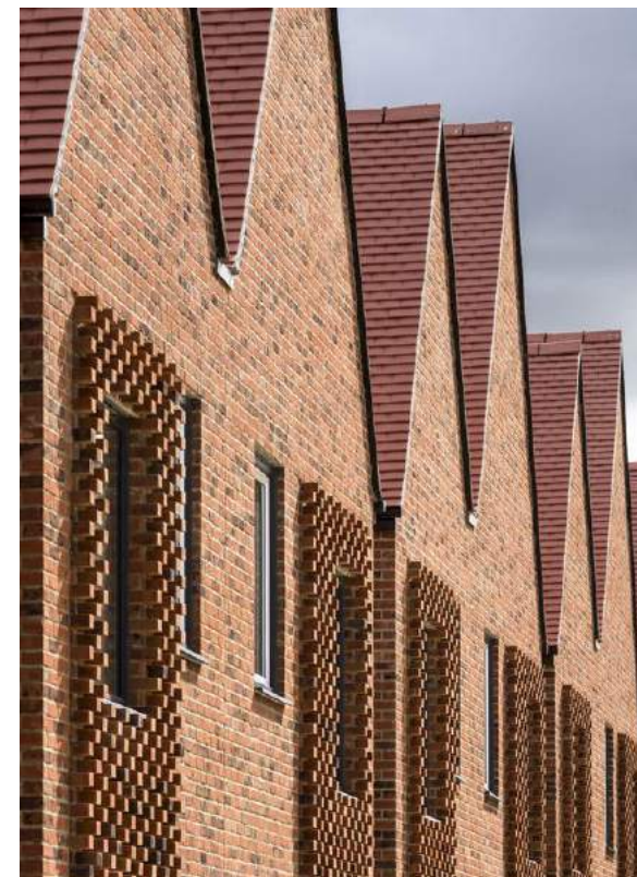
DE WONINGEN WORDEN UITGEVOERD IN BAKSTEEN MET RIJKE METSELVERBANDEN.
